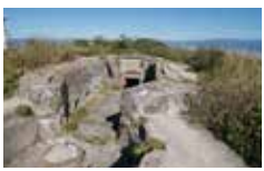
函館山砲台遺跡 (舊要塞設施) ⑥
